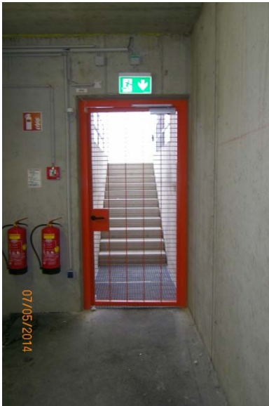
Beispiele von Zuluftöffnungen für Rauch- und Wärmeabzugsanlagen
