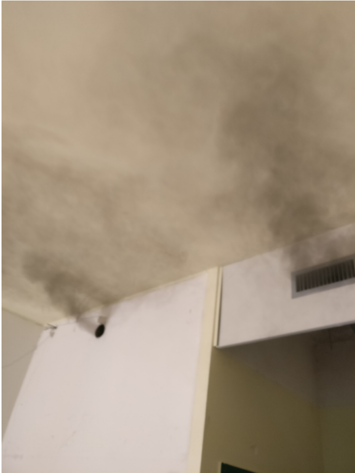
Abbildung 2: Rauchaustritt im Nebenraum kurz nach Deaktivierung der Lüftungsanlage beim Versuch 1. Rechts im Bild ist die rechteckige Zuluftöffnung zu sehen und links im Bild die Öffnung zum Abluftkanal.
