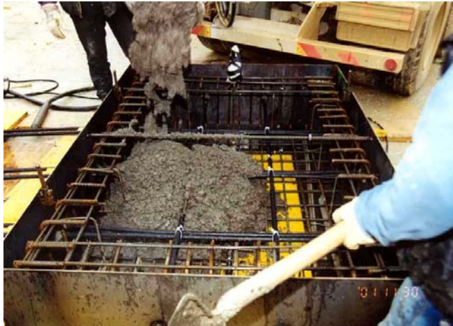
Abb. 1: Betonieren Versuchskörper VK04
