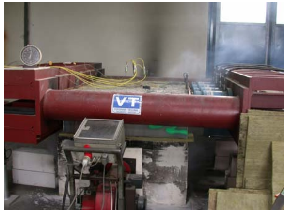
Abb. 4: Vorspannung mit Spannrahmen
